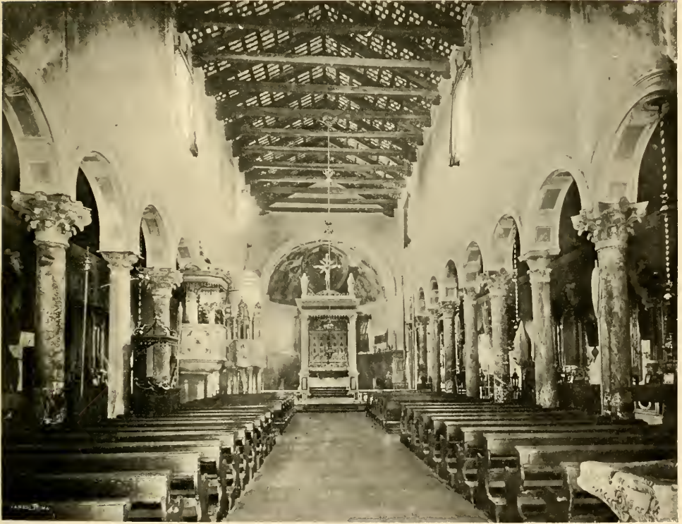
Fig. 155 — Interno del duomo di Grado (a. 571-586)
